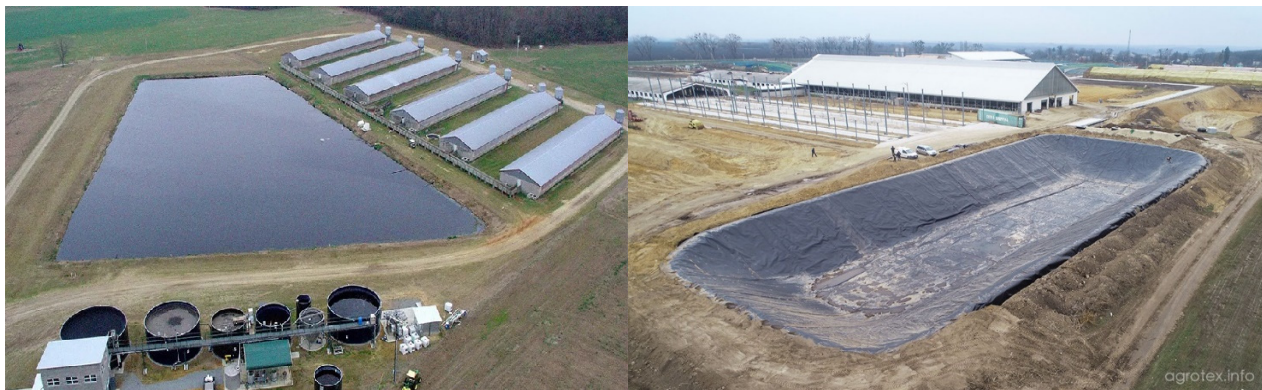
Рисунок 1. Примеры устройства навозохранилища (пометохранилища) по типу «лагуна» (слева заполненная, справа незаполненная)
