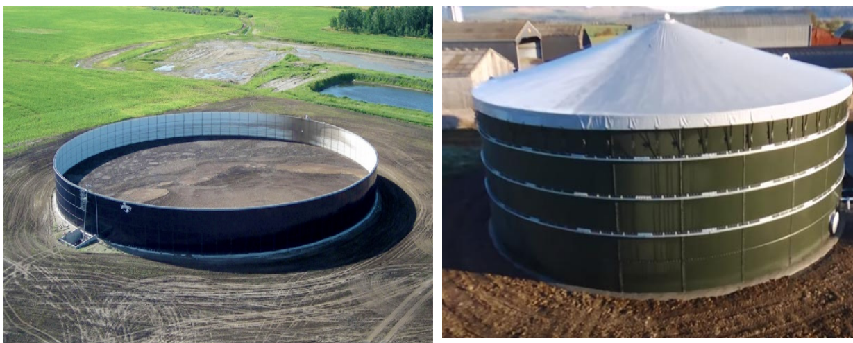
Рисунок 2. Примеры устройства навозохранилища (пометохранилища) по типу «наземный резервуар» (слева открытый, справа закрытый)
